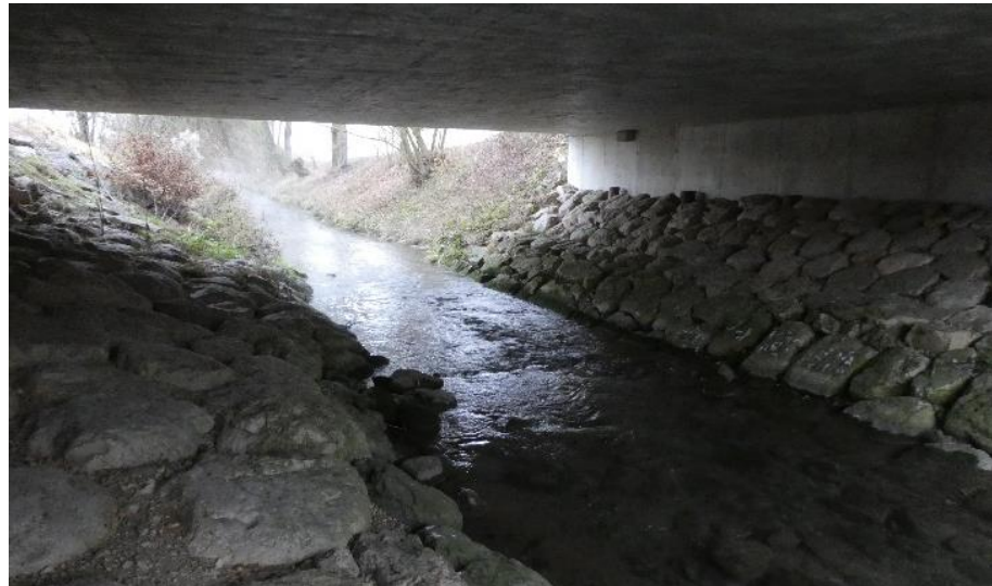
Abb. 3 Geeignete Brücken haben einen fast höhlenartigen Charakter und weisen mindestens auf einer Seite ein Bankett oder aus dem Wasser ragende Steine auf.
